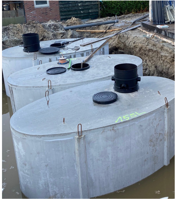
Foto 3: Varitank Filterschacht op geschakelde betonnen warmteputten.
